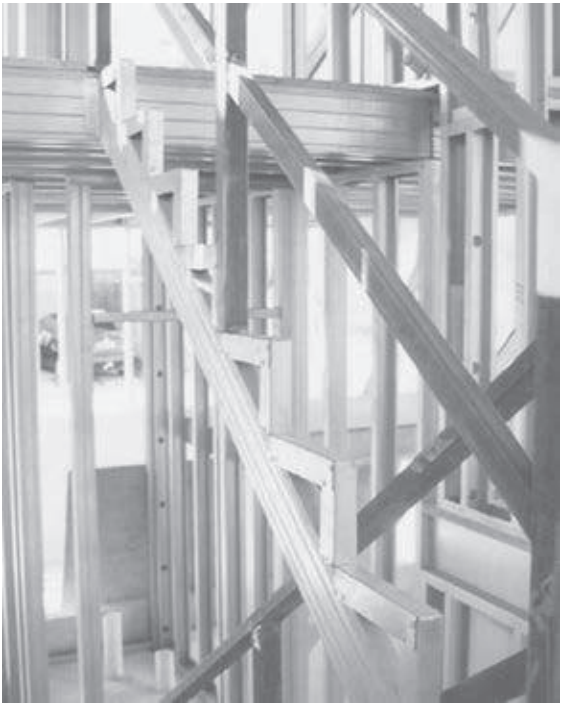
Foto 4.8 - Escada viga caixa inclinada
