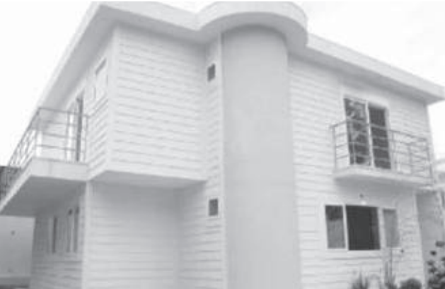
Foto 2.5 - Residência em São Paulo – SP (Wall Tech)
