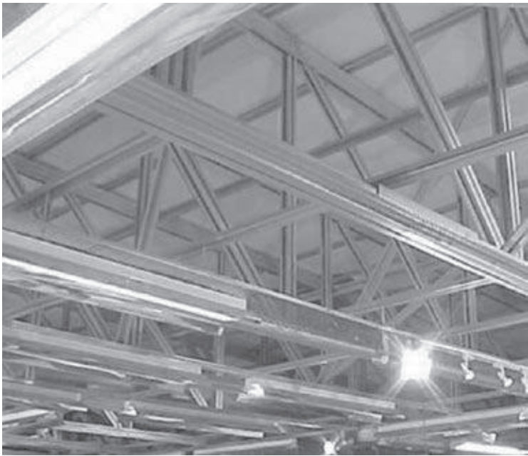
Foto 5.1 - Treliças planas (Fonte: http://www.aegismetalframing.com )
