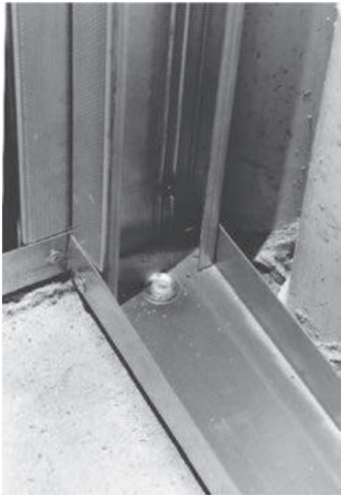
Foto 2.14 - Ancoragem provisória
