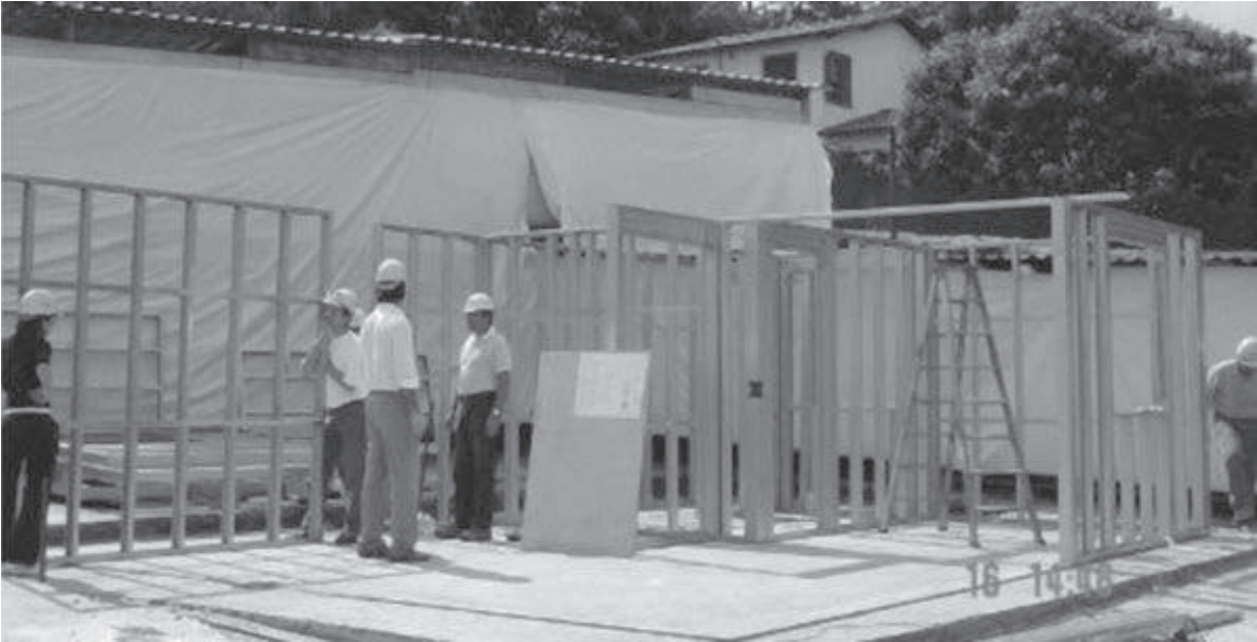
Foto 2.10 - Elementos estruturais como tesouras e painéis são pré-fabricados em oficinas e levados à obra para montagem da estrutura (Fonte: http://www.aegismetalframing.com ).
