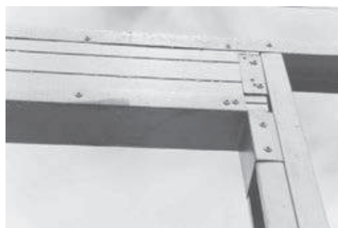
Foto 3.2 - Detalhe de verga para abertura de janela
