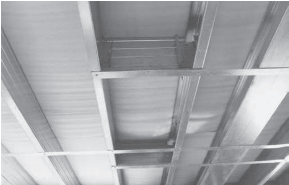
Foto 4.7 - Travamento horizontal da laje de piso por meio de bloqueadores e fitas metálicas
