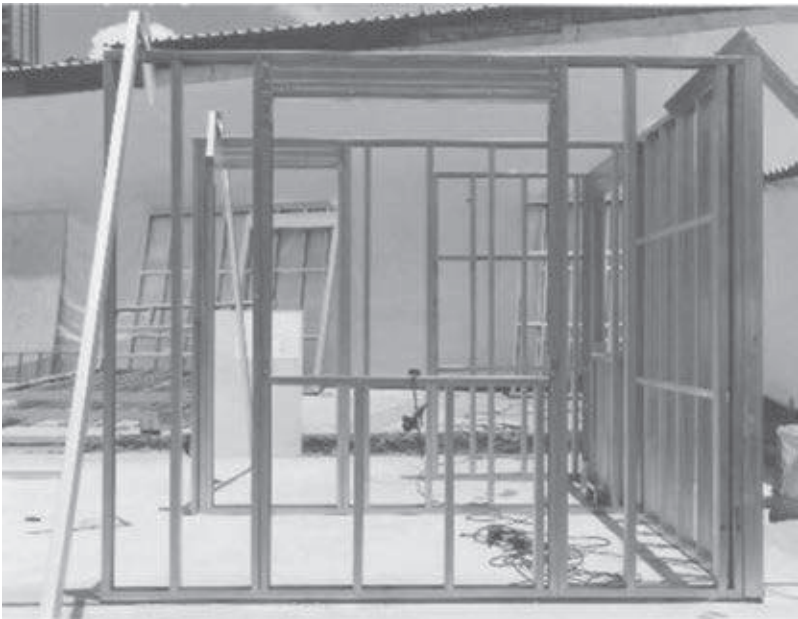
Foto 3.1 - Painel com abertura de janela
