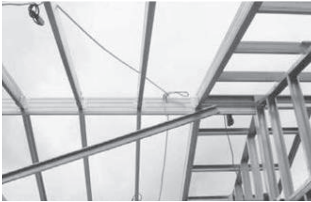
Foto 5.3 - Cumeeira composta de perfis U e Ue para apoio dos caibros
