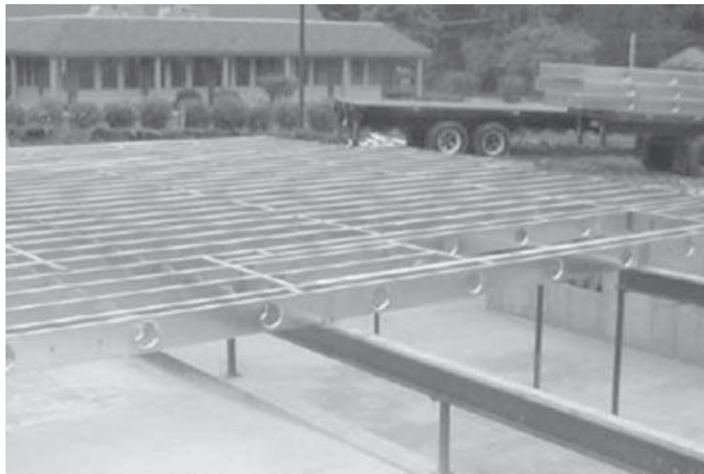
Foto 4.6 - Vigas de piso apoiadas sobre viga principal em aço (Fonte: http://www.aegismetalfaming.com )
