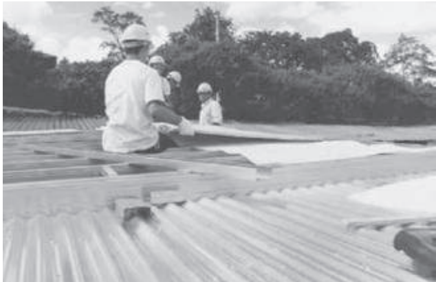
Foto 4.2 - Forma de aço para contrapiso úmido
