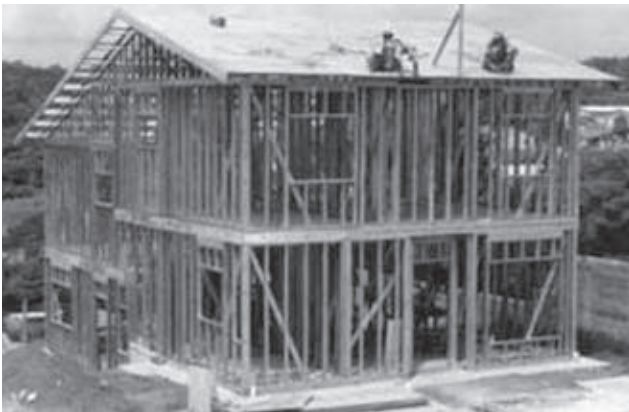
Foto 2.1 - Estrutura de residência em Light Steel Framing, São Paulo (Fonte: Construtora Sequência)
