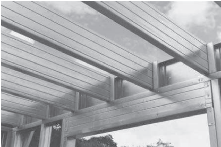
Foto 4.1 - Vigas de piso
