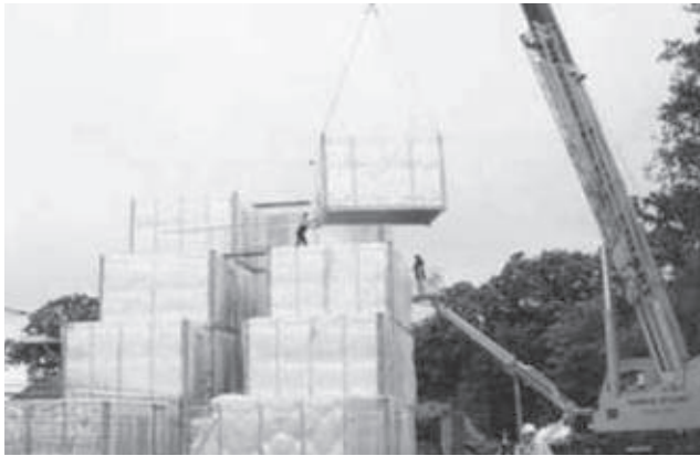
Foto 2.11 - Unidades modulares empilhadas na forma da construção final. O vazio que se vê ao centro formará a circulação de acesso às unidades (Fonte: SCI).
