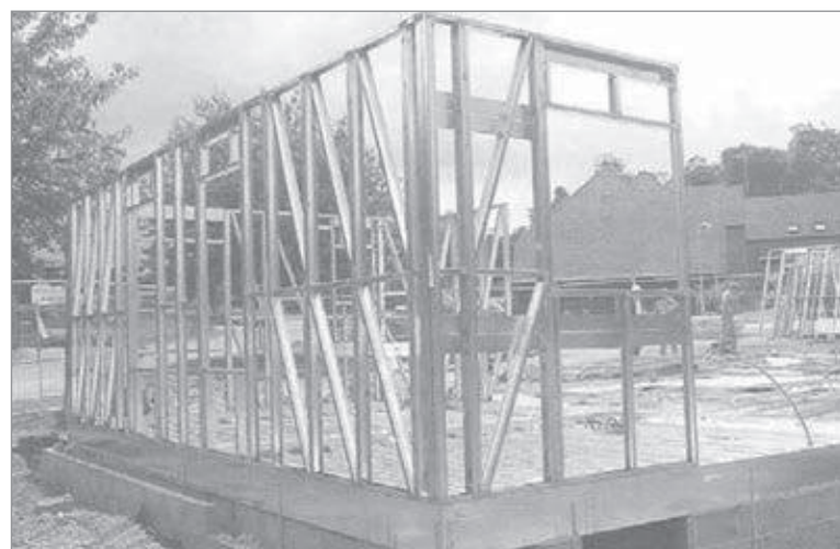
Foto 3.5 - Contraventamento em "K" (Fonte: SCI)
