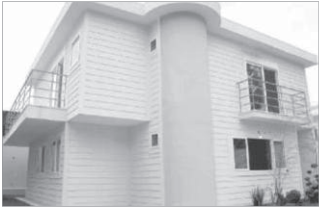
Foto 3.7 - Residência em São Paulo - SP (Wall Tech)
